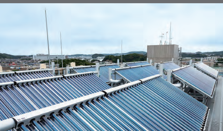
●第103建物屋上に設置された太陽熱エネルギー設備
